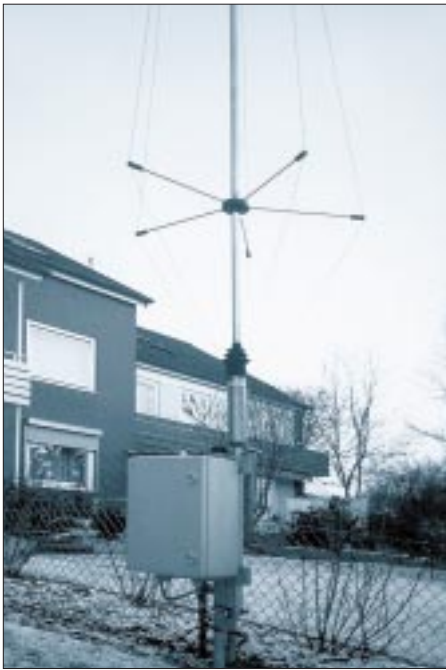
Bild 9: Die Antenne mit Blickrichtung Süd-osten
