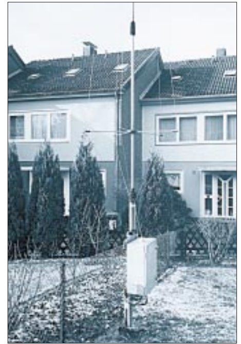
Bild 10: Diese Ansicht der Antenne (mit Blickrichtung Westen) zeigt Einzelheiten der Montage und des ABS-Gehäuses für die Unterbringung des Smartuners. Fotos: DJ2EV
